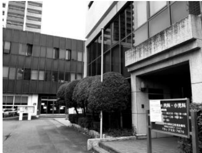
手前：旧休日急患診療所 奥側：旧中原区保健所
